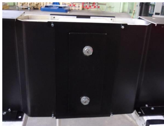
Inserire il giunto monobullone.... Insérer le joint monobloc.... Insert the monoblock joint....
