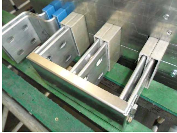
Exemple d'installation de l'élément anti-glisement
